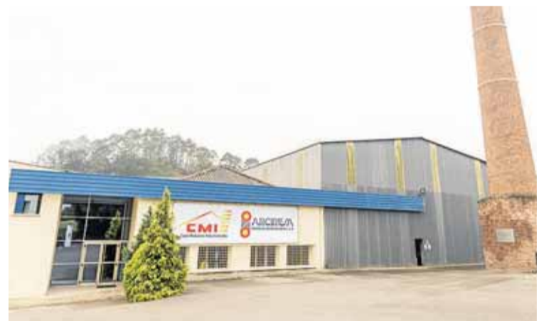
Nuevas instalaciones de CMI Casas Modulares, en Carbaínos.
